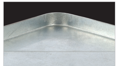
3. Schritt: Die Ecken auf die korrekte Höhe schneiden.
